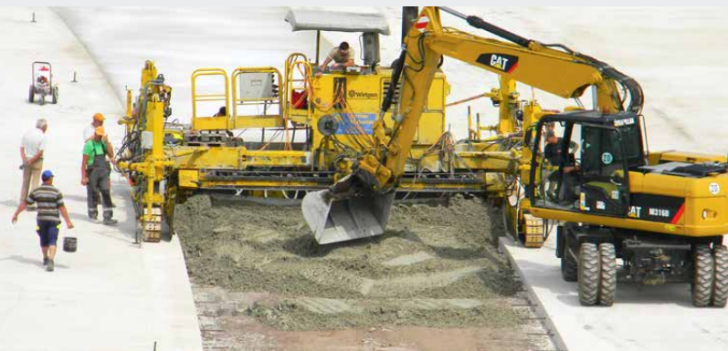
Betoneinbau mit SP 500 in der Hafenanlage Minden
